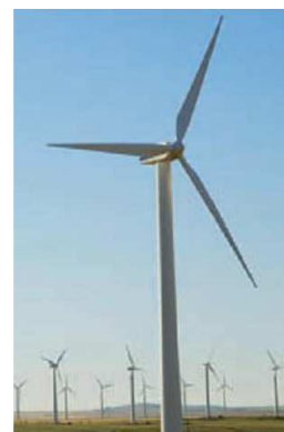
8. ábra. Textilanyaggal erősített kompozitból készült szélkerék-lapátok
